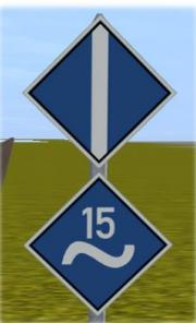
Ähnlich wie bei der Kombination des Einschaltsignals (E12) mit dem Systemwechselsignal kann auch das „Bügel an“ Signal (E15) mit einem solchen Signal kombiniert werden.
